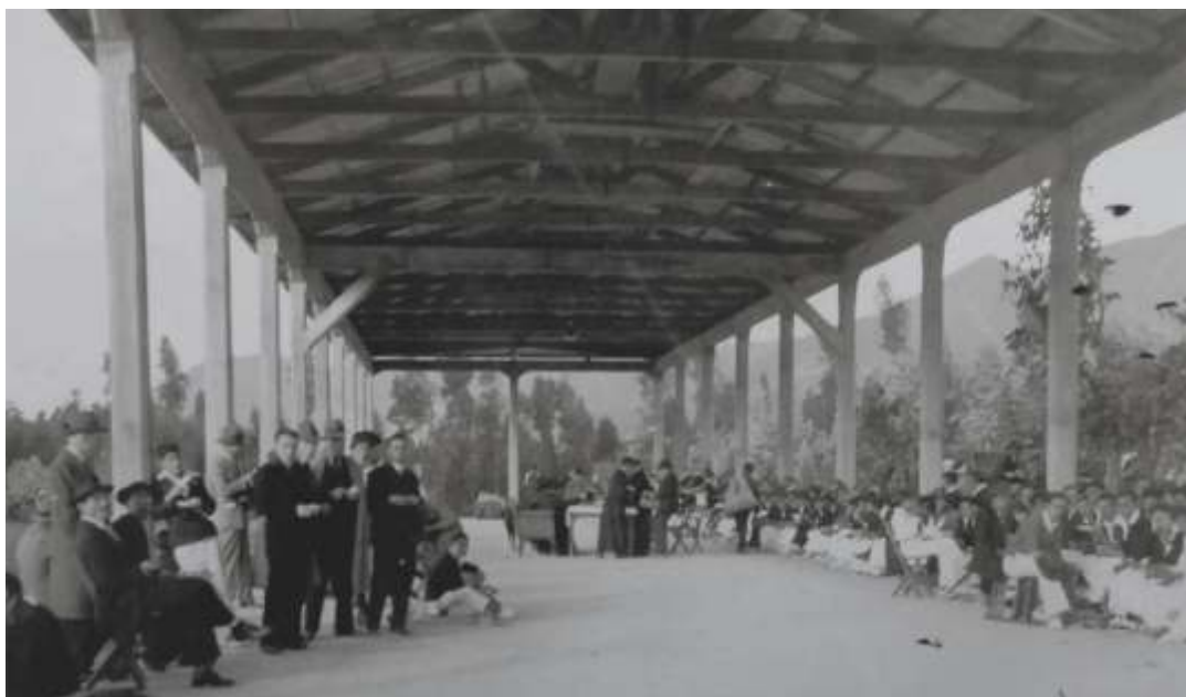
Antigua estructura del "Tinglado", ubicada atrás de la actual iglesia que antecedió al santuario, barrio Suramerica, Bogotá. Aquí la realización de un desayuno con los habitantes del barrio Suramérica y del barrio 20 de Julio. Fuente: Memoria Histórica Salesiana COB, 1937.
